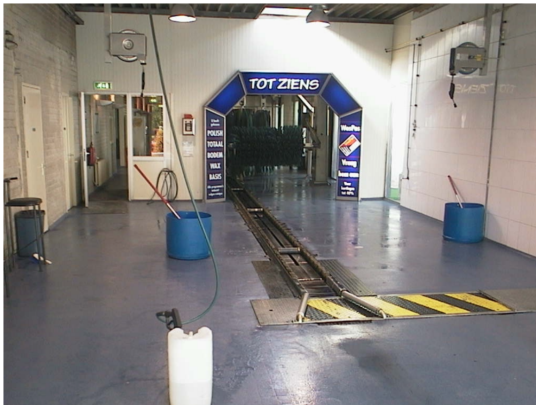
Foto: Voorbeeld te inspecteren vloeistofdichte voorziening.
