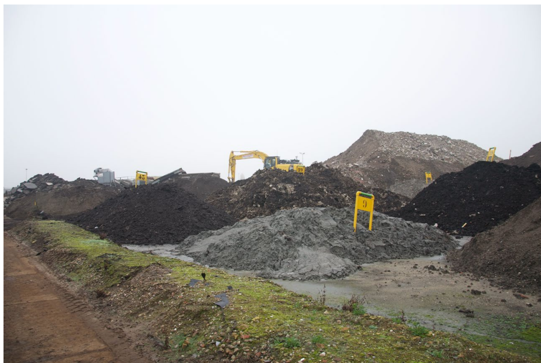
Foto: Mogelijke inspectielocatie voor geo-elektrische meting.
