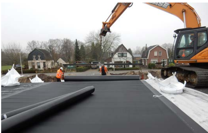
Foto: aanbrengen HDPE-Folie
