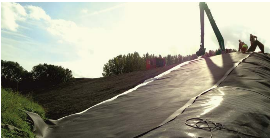
Foto: overzicht aanleggen IBC werk.
