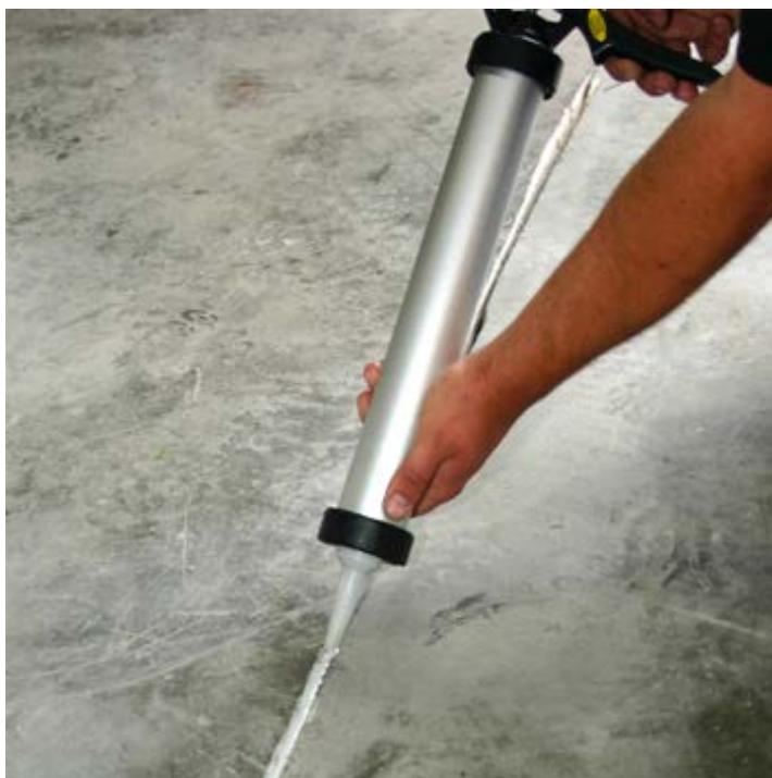
Foto: Aanbrengen voegvulmassa.
