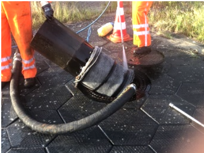
Foto: Controle ingebouwde onderdelen afscheidingsinstallatie
