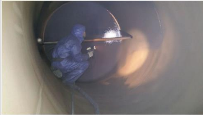
Figuur 6-2: aanbrengen coating
