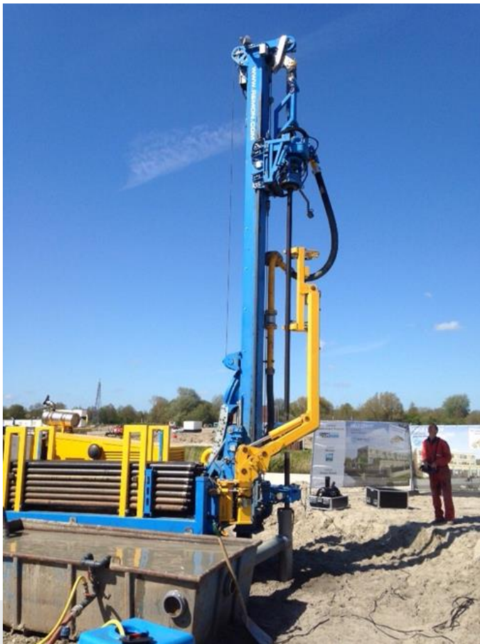
Boring in uitvoering.
