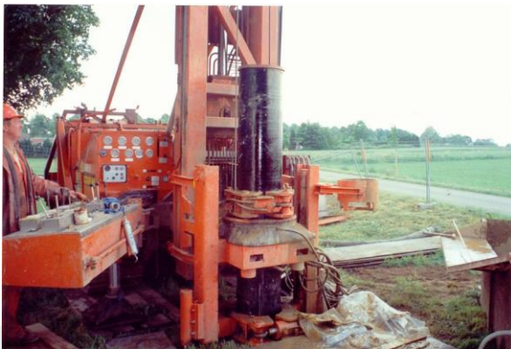
Pulsboring in uitvoering.
