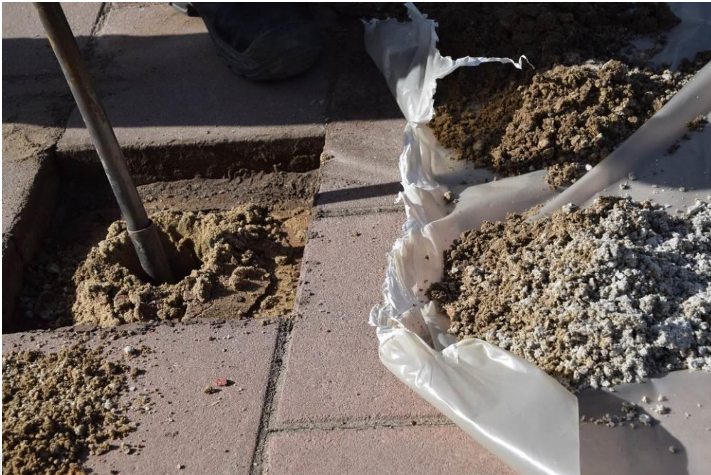
Uitvoering handboring onder verharding en uitleggen opgeboord materiaal.
