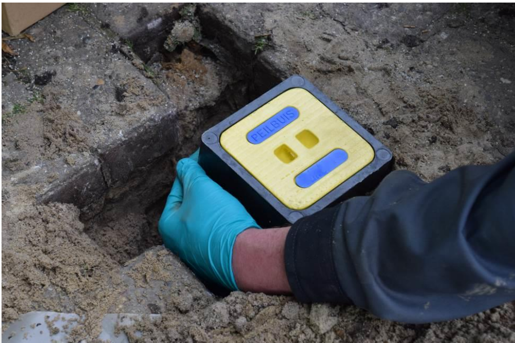
Plaatsen straatpot over peilbuis.
