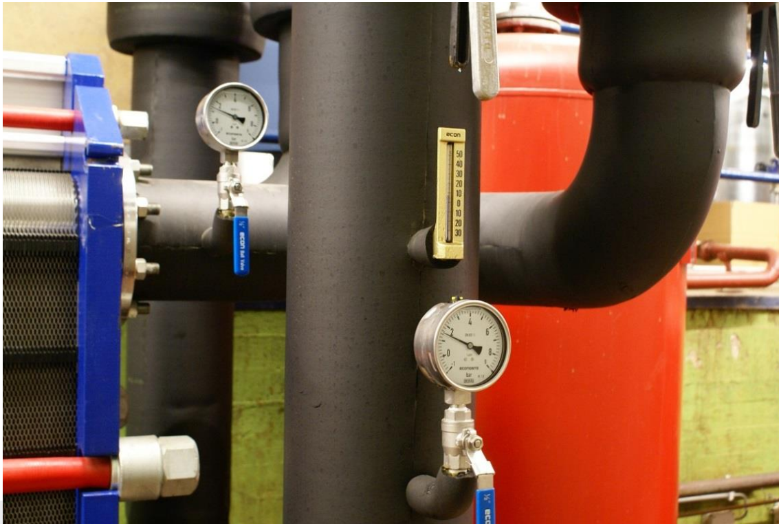
Meetinstrumenten: indicatoren voor druk en temperatuur.
